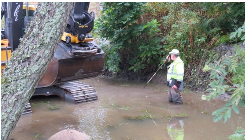
Eero Hakala antaa ohjeita kaivurikuskille Jimmy Bergströmille Nyborgin tilan kohdalla.
