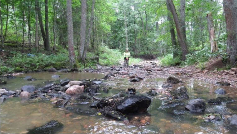
Kolme valmiiksi rakennettua kutosoraikkoa ja poikaisalue Sunnanån kosken kohdalla (Eero Hakala kuvassa takaalalla).
